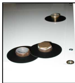
kuva verholiitännästä venttiili asennettuna
