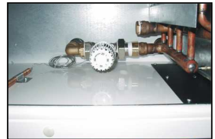
kuva sisäänrakennetusta termostaattiventtiilistä
